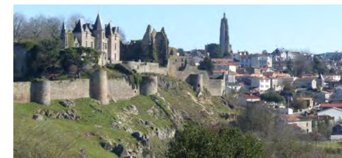
10. Eglise Notre-Dame, vue depuis l'angle de la rue de la Thude et de la rue de Bel Air
