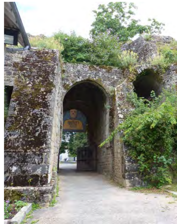
La porte d'entrée de la 2 e enceinte, aujourd'hui, vue depuis l'intérieur
