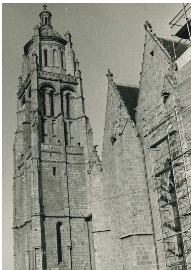
La façade sud en cours de travaux en 1984 Source : dossier DRAC Nouvelle-Aquitaine
