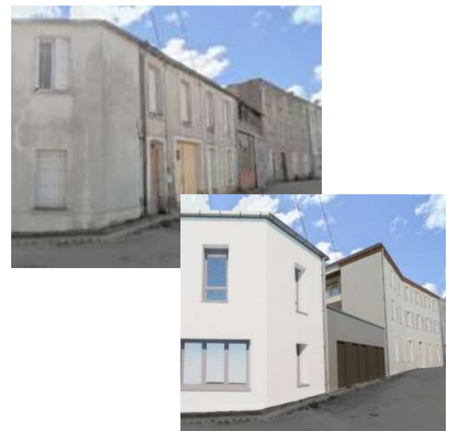
Projet logements locatifs DSH, Mauléon
