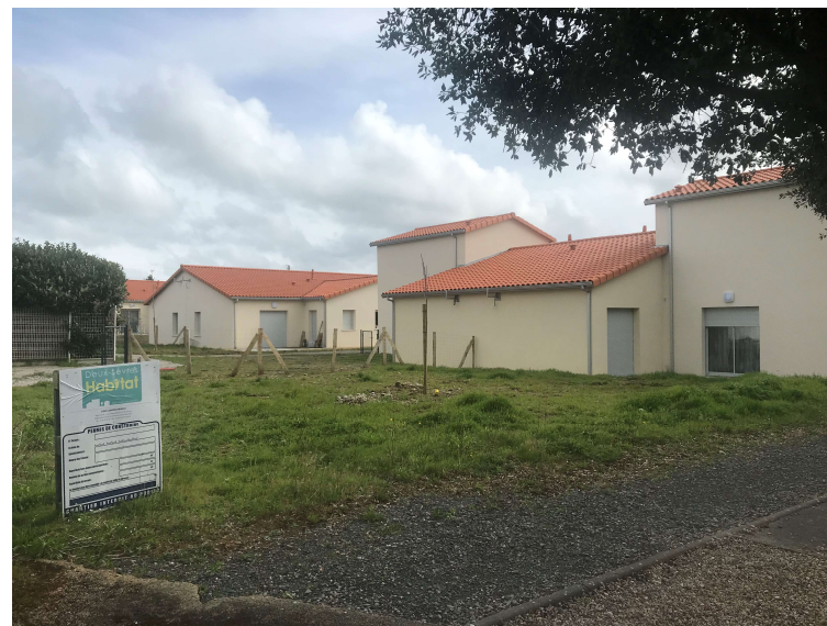
Logements locatifs DSH à Nueil-Les-Aubiers
