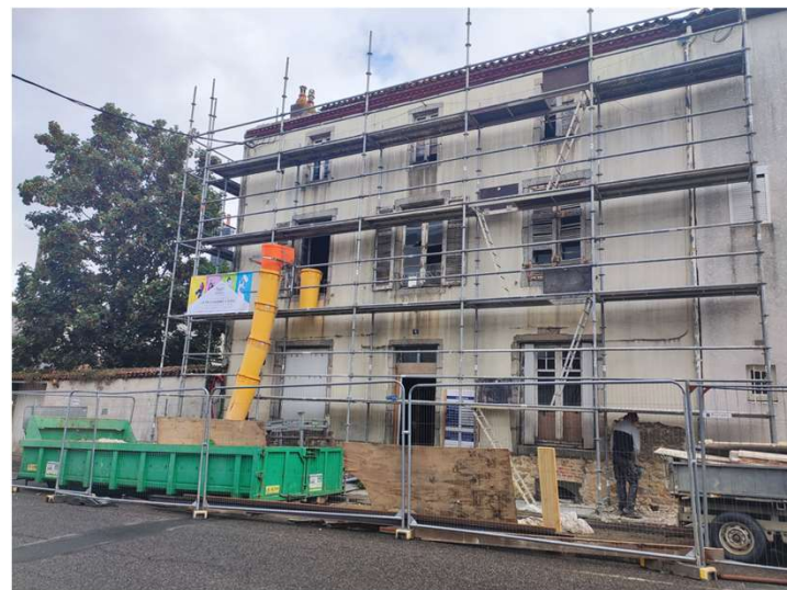
Programme AggloRénov : Immeuble en cours de rénovation, 2023
