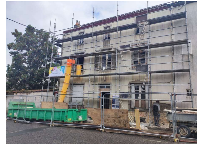
Chantier en cours, 2023
