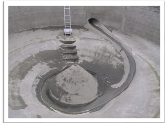
Bassin tampon de Caphar à Nueil-Les-Aubiers
