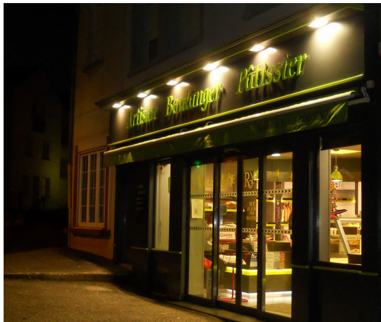
Éclairage intégré dans le bandeau
