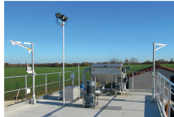
Dalle bassin aération avec prétraitements
