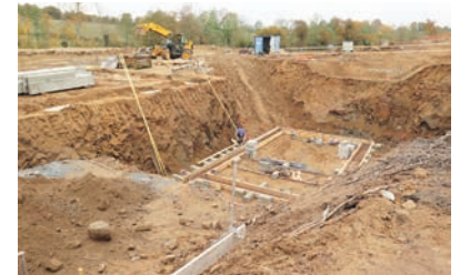
Les fondations du bâtiment ont été creusées à 3,50m de profondeur.
