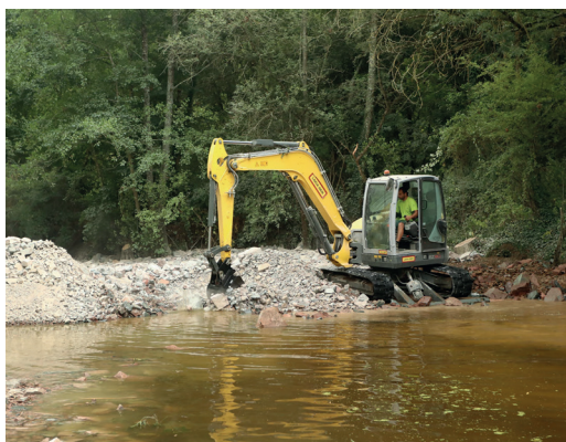
Terrassement des granulats à la pelleteuse
