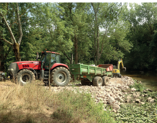
Apport des granulats et création de la rampe d'accès
