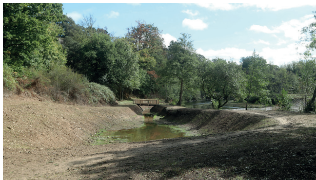
La frayère après travaux
