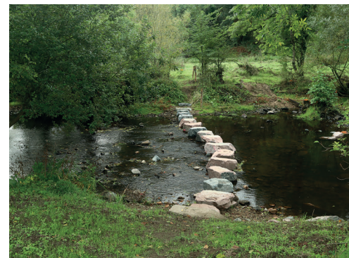
Passage à gué piéton submersible
