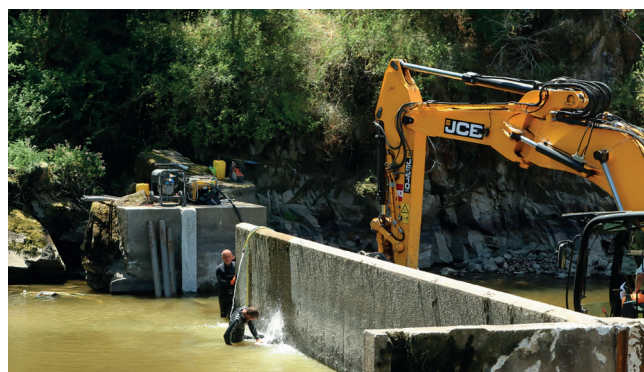
Sciage du barrage en béton
