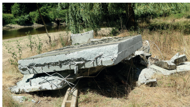
Blocs de béton découpés et exportés en centre de traitement
