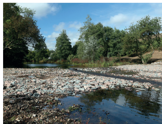
Réhaussement réalisé près de la station d'épuration en amont du barrage
