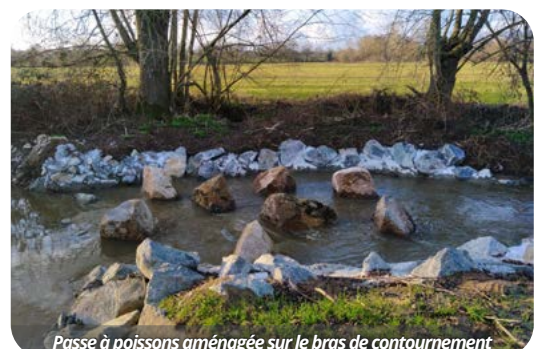
Passé à poissons aménagée sur le bras de contournement
