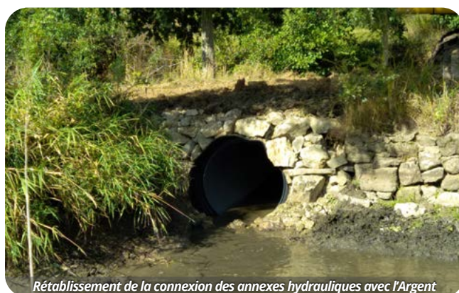
Rétablissement de la connexion des annexes hydrauliques avec l'Argent
