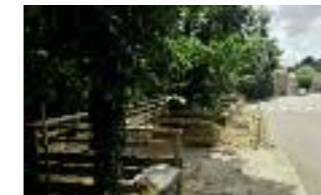
Aménagement de circulations piétonnes à ST GELAIS (79)
