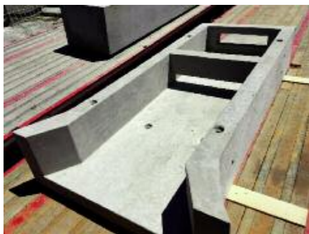
Caniveau pour passage d'eau.
