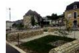
Aménagement de la rue des Halles à AIRVAULT (79)
