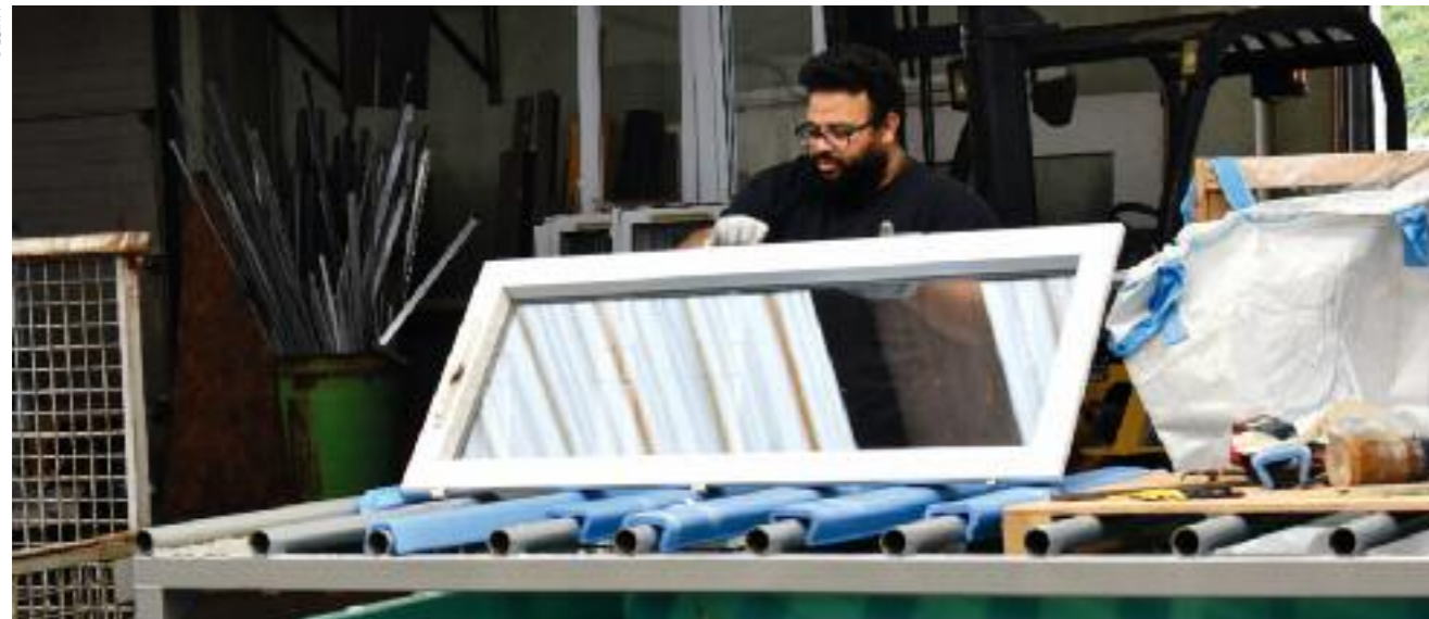
Le démantèlement de fenêtres : une activité de l’ESIAM, entreprise à but d’emploi.
